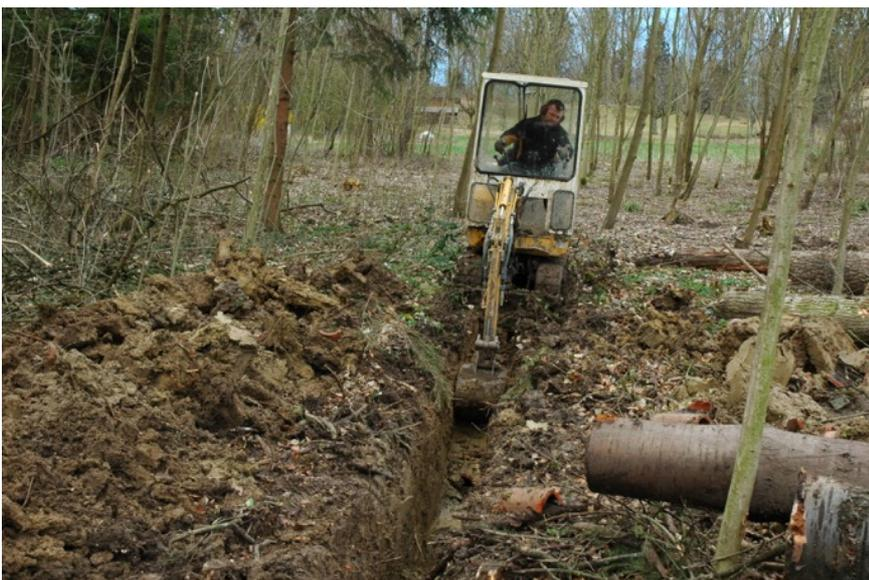
Fig. 8.4 : Une conduite de drainage est extraite à l'aide d'une petite pelleteuse afin de créer un ruisseau à ciel ouvert.
