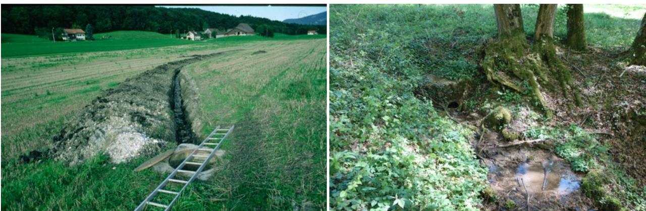
Fig. 3.3 : Drainage d'une surface cultivée en milieu ouvert (à gauche) et émergence artificielle de l'eau d'une source de prairie dérivée vers une lisière de forêt (à droite).
