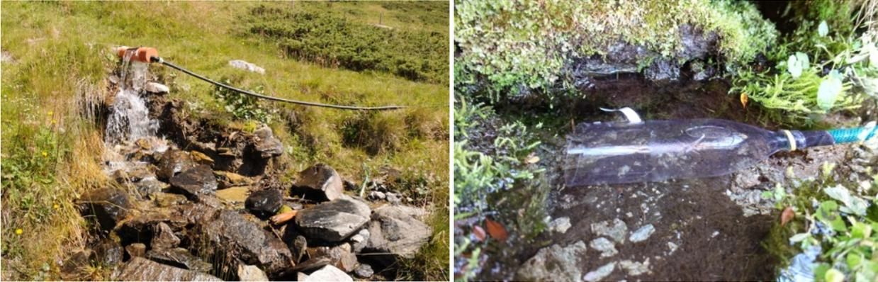
Fig. 8.9 : Dérivation de l'eau d'une source. Dans cet exemple, seule une petite partie du débit est détournée. Le reste de l'eau est à la disposition de la biocénose de la source (à gauche). Dérivation improvisée à partir d'un milieu de source pour l'alimentation d'un bâtiment d'alpage (à droite).
