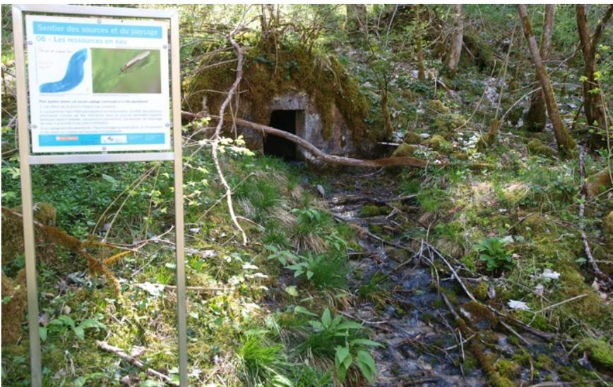
Fig. 8.2 : Après l'obstruction de la conduite, l'eau déborde de la chambre de captage pour former un milieu fontinal.
