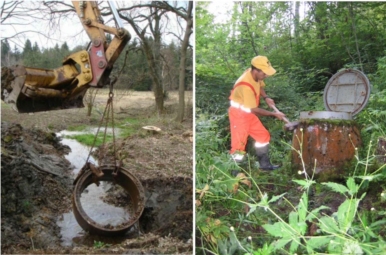
Fig. 8.1 : Démantèlement d'un captage de source. Les éléments de construction sont retirés avec le plus grand soin.
