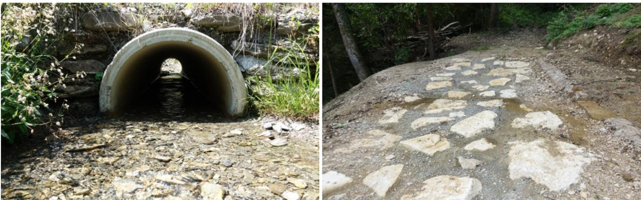
Fig. 8.7 : La section du tuyau est remplie d'environ un tiers d'alluvions (à gauche), ce qui est considéré comme suffisant pour permettre à la petite faune de remonter vers la zone de la source. Sur les chemins forestiers rarement empruntés, un gué peut être aménagé pour la traversée du ruisseau de la source (à droite).
