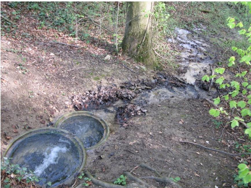
Fig. 8.8 : Source captée dans sa partie supérieure dans des anneaux de puits en béton. Les zones de transition terre-eau ne peuvent pas se développer à cet endroit.
