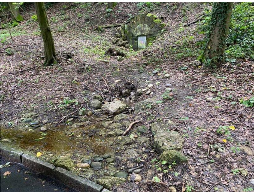
Abb. 8.21: Das Wasser aus einer historischen Quelfassung in einem Park bildet einen kleinen Quellbach, wird anschliessend in einem Wassertank gespeichert und im Sommer zur Bewässerung des Parks verwendet.
