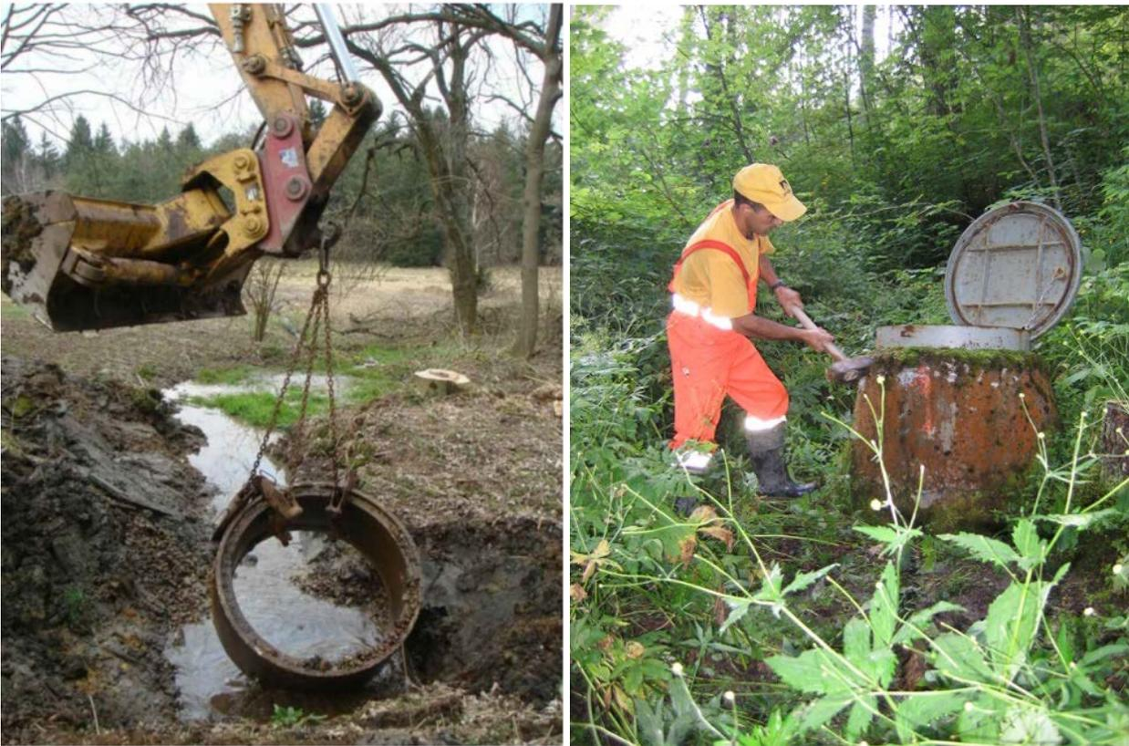
Abb. 8.1: Rückbau einer Quellfassung. Die Bauwerkteile werden mit grosser Sorgfalt entfernt.
