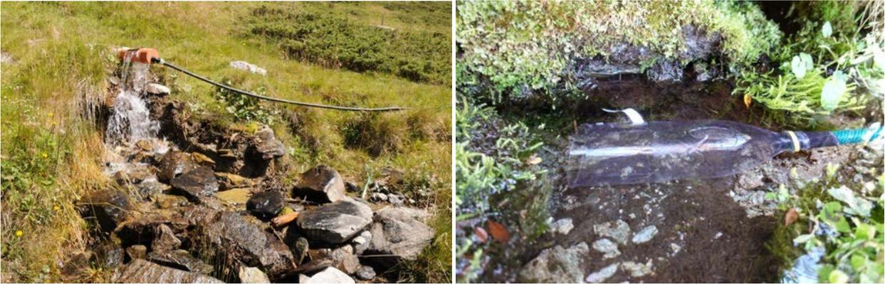
Abb. 8.9: Wasserableitung aus einer Quelle. In diesem Beispiel wird nur ein kleiner Teil des Abflusses abgeleitet. Das übrige Wasser steht der Quell-Lebensgemeinschaft zur Verfügung (links). Improvisierte Ableitung aus einem Quell-Lebensraum für das Gebäude einer Rinderalp (rechts).
