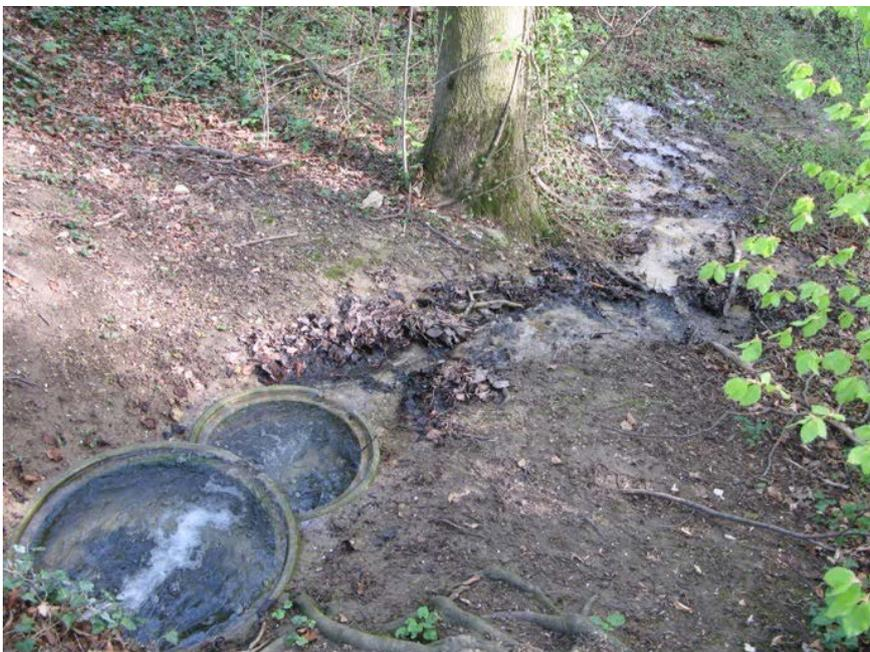
Abb. 8.8: Die Quelle wurde im oberen Bereich mit Schachtrohren gefasst. Die sickernden Übergangsbereiche Land-Wasser konnten sich deshalb nicht entwickeln.
