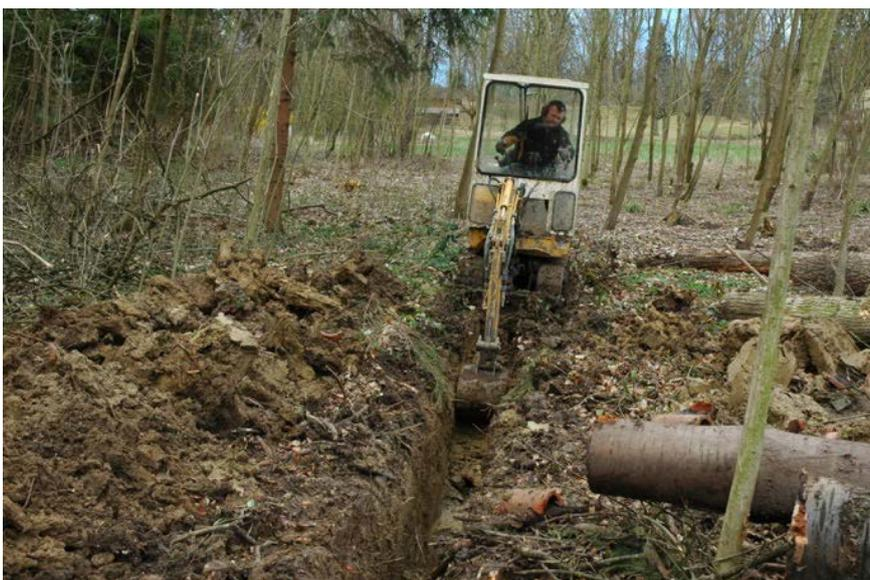
Abb. 8.4: Mit einem kleinen Bagger wird eine Drainageleitung ausgegraben, um einen offenen Quellbach zu schaffen.
